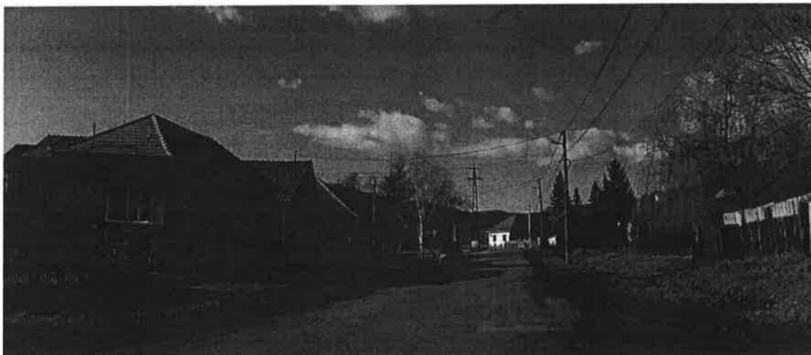
2-20. ábra: 25. sz. főút (Hódoscsépany – Munkás úti körforgalom közötti szakasz)
