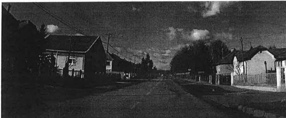
2-13. ábra: Szentsimon út – Bolyki főút (Ózd belterület – Bolyki Tamás utca keleti vége közötti szakasz)
