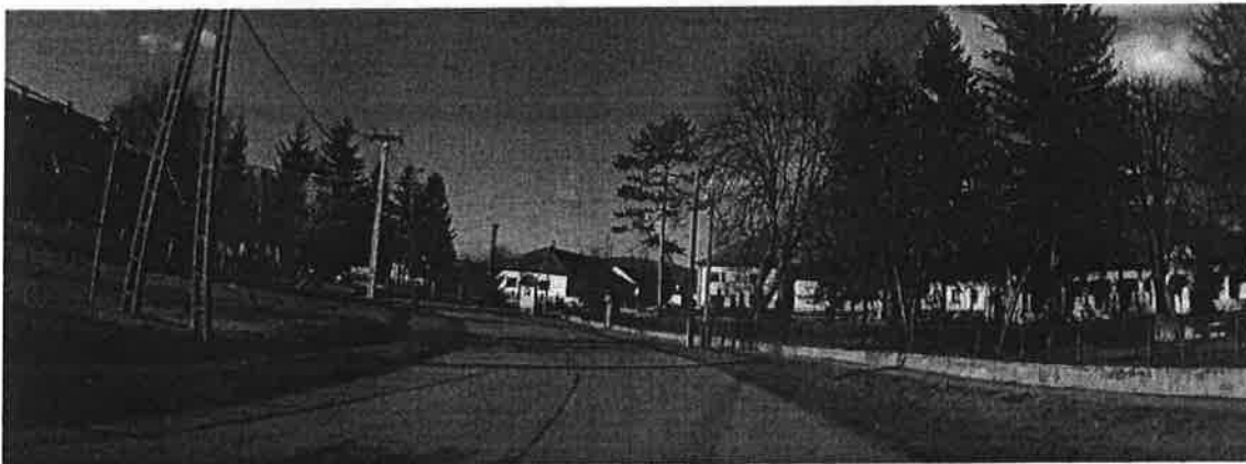
2-12. ábra: Szentsimon út – Bolyki főút (Ózd belterület – Bolyki Tamás utca keleti vége közötti szakasz)
