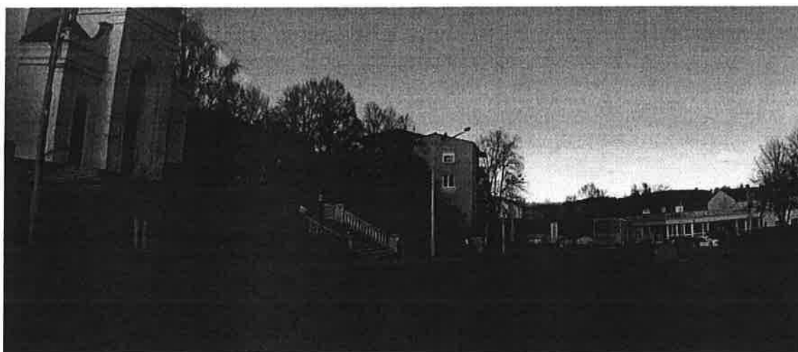
2-24. ábra: Ív út (Bajcsy-Zsilinszky E. utca és Szabó Lőrinc u. közötti szakasz)
