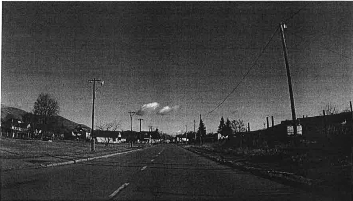
2-4. ábra: Kőalja út (Akácós út– 25. sz. főút közötti szakasz)
