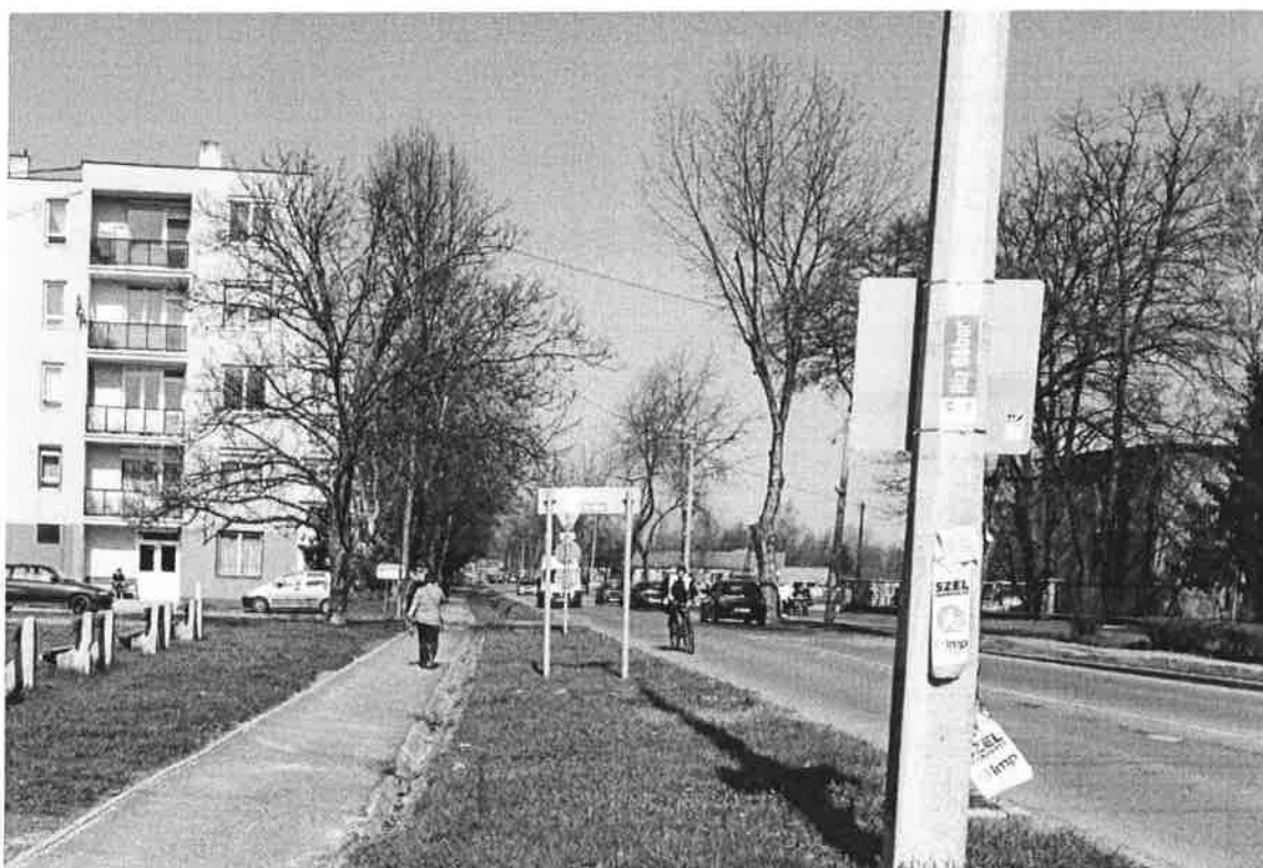
2-1. ábra: Bolyki főút (Bolyki Tamás utca keleti vége és Brassói út közötti szakasz)
