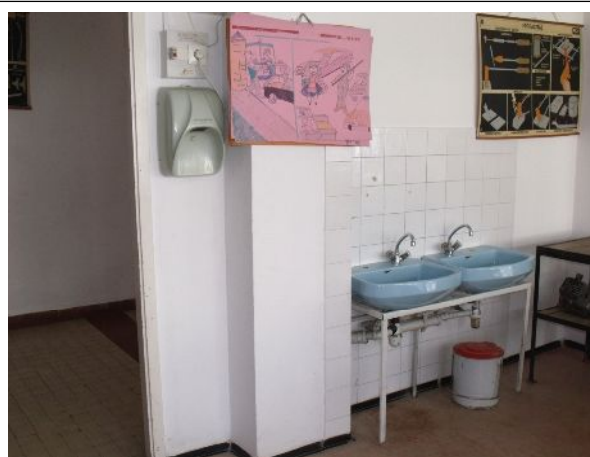
Utólagosan aláfalazott hátsó (szomszéd felőli) fal
