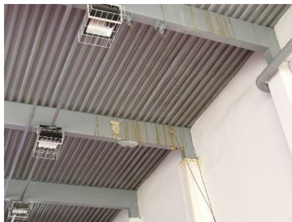
Befalazott árkád és tető részlete az udvar felől II
