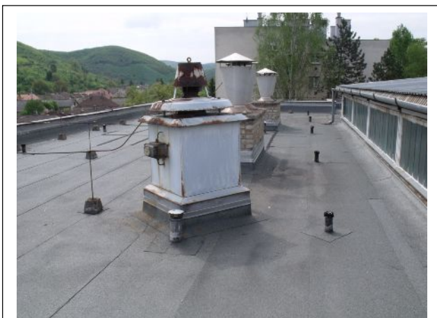
Tetőfelépítmények és szigetelések
