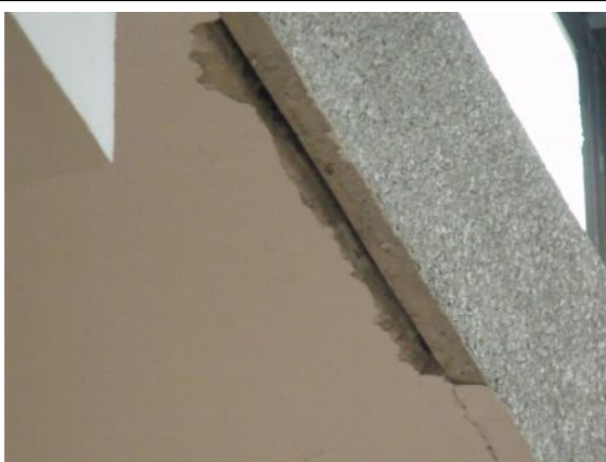
Panelcsatlakozás hiányossága
