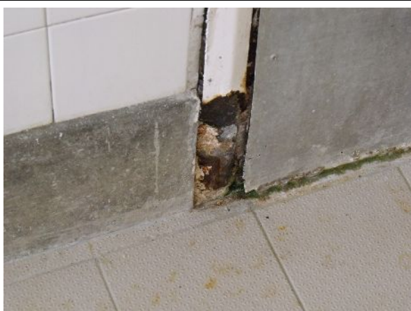
Nyílászárók korrodálása
